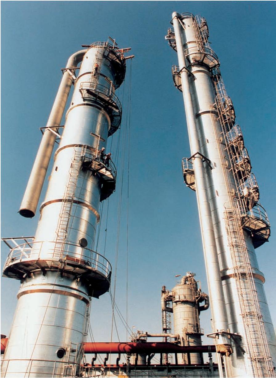
◀ Packungskolonne DN 4000 während der Montage von Montz-Pak Typ B1-250.
