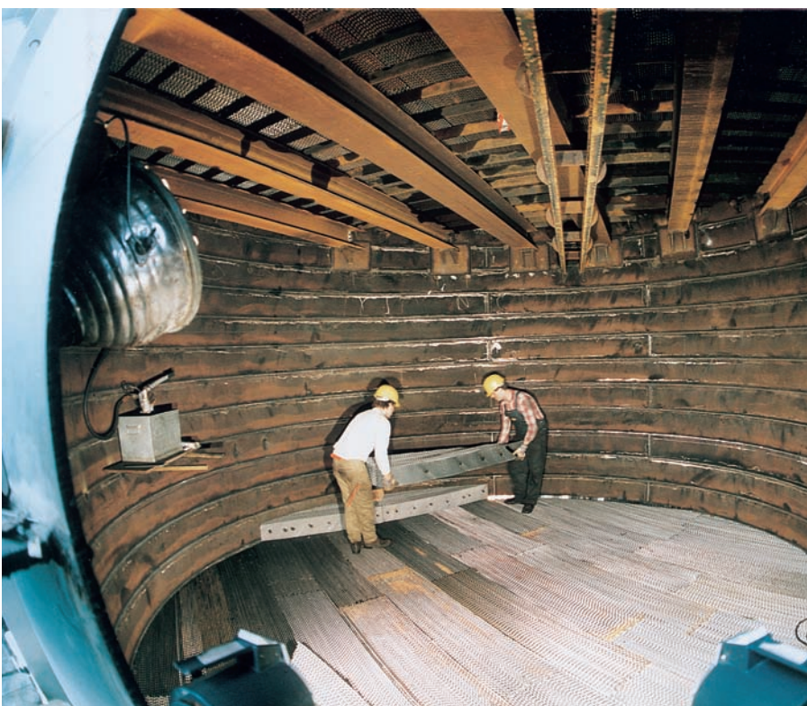
◀ Einbau der Montz-Pak Typ B1-300 in eine Kolonne DN 5600, aus der vorher die vorhandenen Ventilböden demontiert wurden. Alle Auflageringe sind mit Schneidbrennern herausgetrennt worden.
